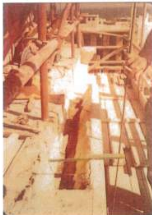
εικ. 5-23: Κατασκευή περιμετρικού εξωτερικού Α' διαδύματος από σκυρόδεμα. Δεκαετία 1980. Αρχείο Βασιλείου
