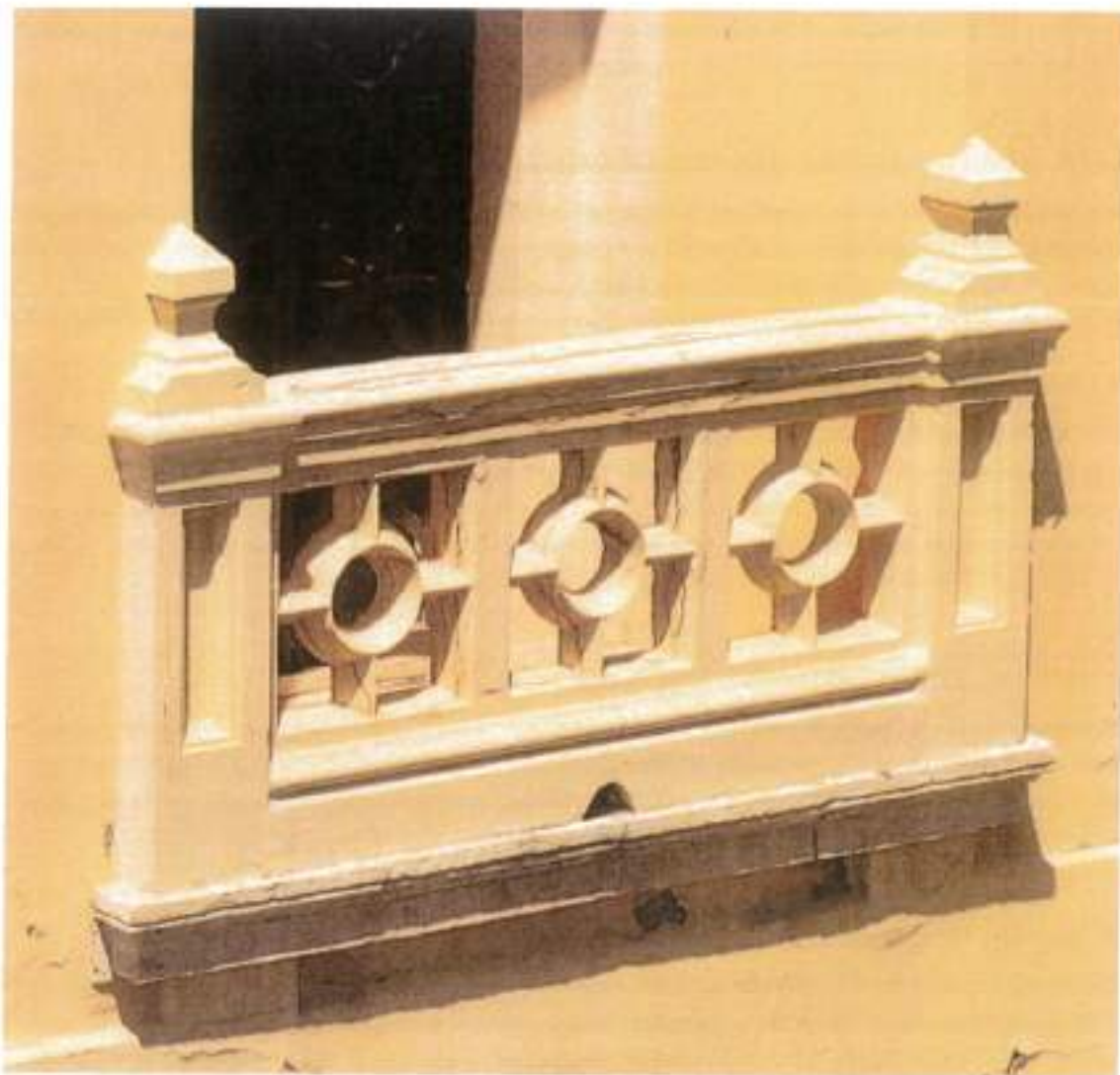
εικ. 7-9 : Στήθα 3 ου επιπέδου βόρσιου κωδωνοστασίου για το οποίο προτείνεται αντικατάσταση με ινοπλισμένο σκυρόδεμα
