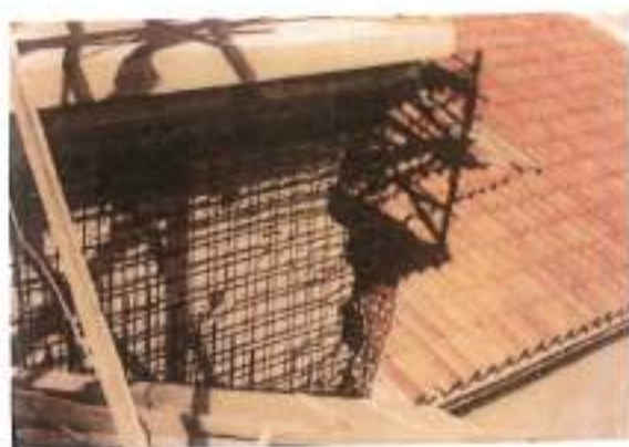
εικ. 5-39: Ανακατασκευή μονόβλο στη βάση του τυμπάνου του τρούλου, 1992, Αρχείο Βασιλάκη
