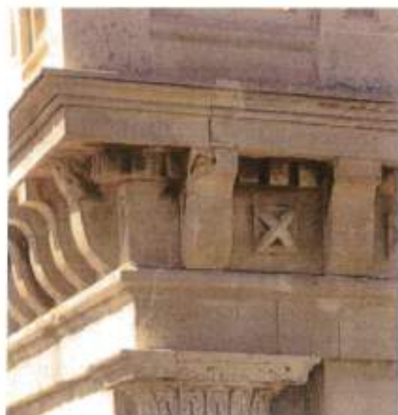
εικ. 6-27: Επίπεδο αστοχίας στο γέσο μεταξύ 4 ου και 5 ου επιπέδου Β Κωδωνοστάσιου.
