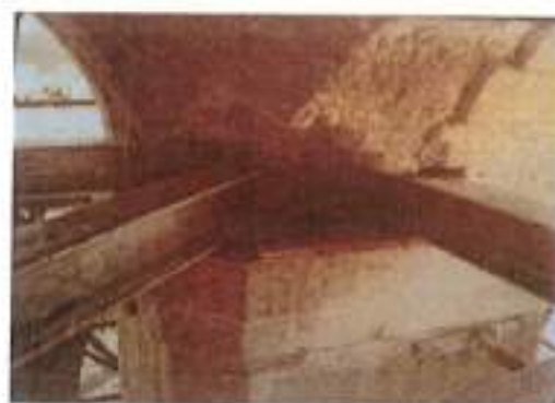
εικ. 5-19: Η στήριξη των μεταλλικών δοκών που φέρουν τις καμπάνες στη γέφυρα των τόξων του Α' διαζώματος. Δεκαετία 1980. Αρχείο Βασιλέου
