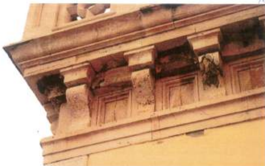
εικ. 7.7 - Οροσημένιος λίθος γύρου 4 ου επιπέδου Β. Ευδιονοστασίου που προτείνεται να αντικατασταθούν.
