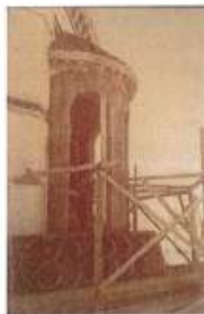
εικ. 5-21: Κάγχη του τρούλου του ναού μετά την ανακατασκευή της από σκυρόδεμα. Δεκαετία 1980. Αρχείο Βασιλείου
