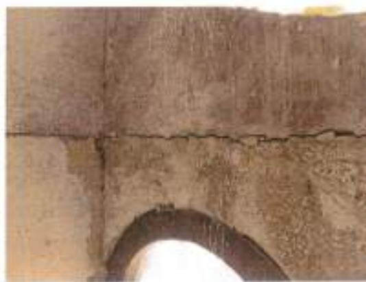
εικ. 6-30: Οριζόντιο επίπεδο αστοχίας, κάτω από το ρολόι του 5 ου επιπέδου και πάνω από τα δίλοβα παράθυρα: εκτεταμένα.
