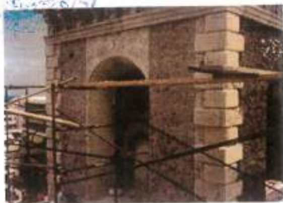
εικ. 5-37: Β. Κυβερνοστόσια, κάτω από το Α' Διάζωμα, τοποθέτηση καλωδίων ενισχυμένων με πλέγμα επιχρισμάτων, 1993, Αρχείο Βασιλάκη
