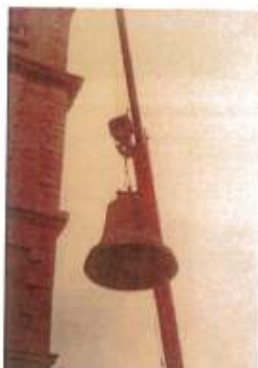
εικ. 5-16: Η καθαίρεση της μεγάλης καμπάνας του Β. κωδωνοστασίου. Δεκαετία 1980. Αρχείο Βασιλέου
