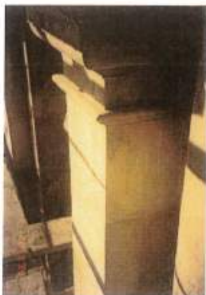
εικ. 5-31: Ν. Κυδωνοστάσιον, Α' Διάδρομος, Β.Α. Κίονας στον οποίο έχουν ανακατασταθεί λίθοι και τμήμα της επικάλυψης. Φθινόπωρο 1991. Αρχείο Θεωλάκη
