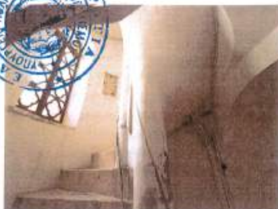
εικ. 4-12: Ελικοειδής κλίμακα β. κωδωνοστασίου. Φαίνεται η μετατόπιση του κέντρου της και τα τυφλά οριζώματα που την περιστοιχίζουν.
