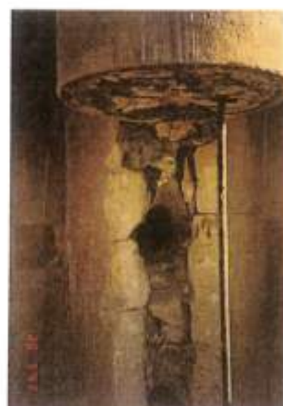
εικ. 5-32: Ν. Κυδωνοστάσιον, Α' Διάδρομος, Ν.Δ. Κίονας κατά τη διάρκεια καθαίρεσης και ανακατασκευής του όπου φαινόταν η χυτοσίδηρη ράβδος της προηγούμενης επάμβλωσης και η τεκτονικοκονιόματη. Φθινόπωρο 1991. Αρχείο Θεωλάκη
