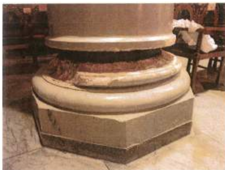
εικ. 4-8: Μεταλλική περίδεση στην έδραση στήλης
