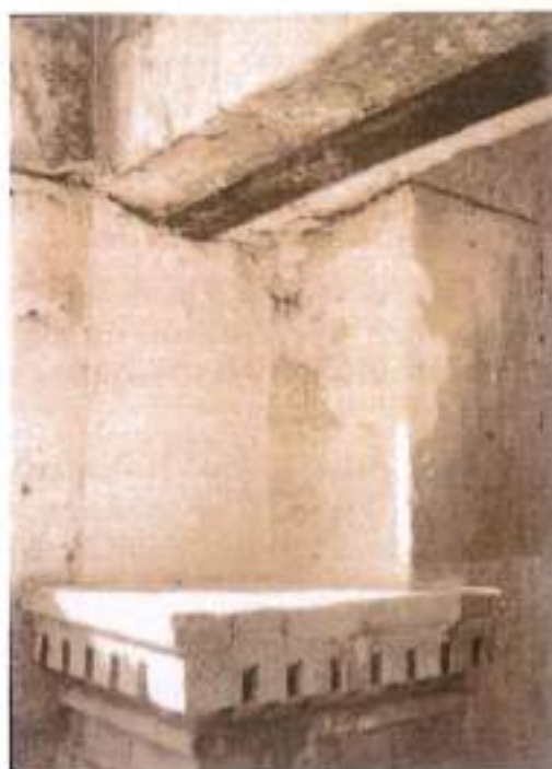
εικ. 5-6: Καθαίρεση έδαφου ανοήματος κάτω από το ρολόι και αποκατάψη σιδερένιας λέρας 50x20 Νότια Καδωνοστασία Νοέμβριος, 1979. Αρχείο Βασιλέως
