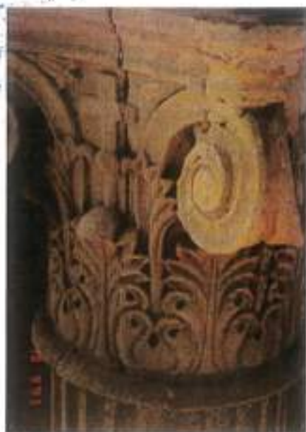
εικ. 5-25: Ν. Καδινωσιτόπου, Β' Διοίκηση, Ραγμές στο κινόνκρανο του Β.Α. Κονο. 1993, Αρχείο Βασιλάνη
