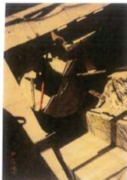
εικ. 5-30: Ν. Κυδωνοστάσιον, Α' Διάδρομος, Ν.Α. Κίονας υπό ανακατασκευή. Τοποθετούνται λίθινοι σπόνδυλοι σε δύο μέρη, κομμάτι στο επωπετικό στη θέση όπου προϋπάρχει η μεταλλική ράβδος. Δεκέμβριο 1990. Αρχείο Θεωλάκη
