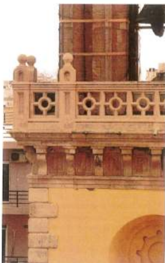
εικ. 7.8 - Οροσημένιος λίθος γύρου 4 ου επιπέδου Β. Ευδιονοστασίου που προτείνεται να αντικατασταθούν.
