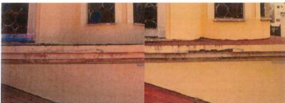
εικ. 6-56 : Απόσπαση επικάλυψης στο αετιά της βάσης του τιμπάνου που είχε επισκευαστεί στο παρελθόν.
