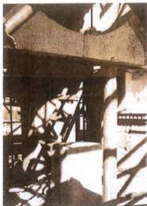
εικ. 5-7: Καθαίρεση έδαφου ανοήματος κάτω από το ρολόι και αποκατάψη σιδερένιας λέρας 50x20 Νότια Καδωνοστασία Νοέμβριος, 1979. Αρχείο Βασιλέως
