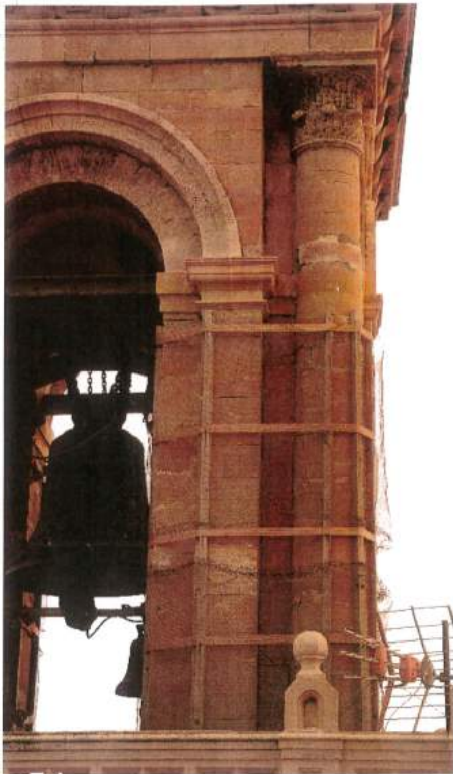
εικ. 7-6 : ΝΑ πύργος Β. Καθολοκοτόπιο, 4 η επιπέδου. Προτείνεται η ανάστροψή των χιτών των πεσσών του επιπέδου αυτού υπό την ελαττωτική πλευρά, καθώς όπως φαίνεται και στην εικόνα είναι σε μεγάλο βαθμό θραυσμένοι.
