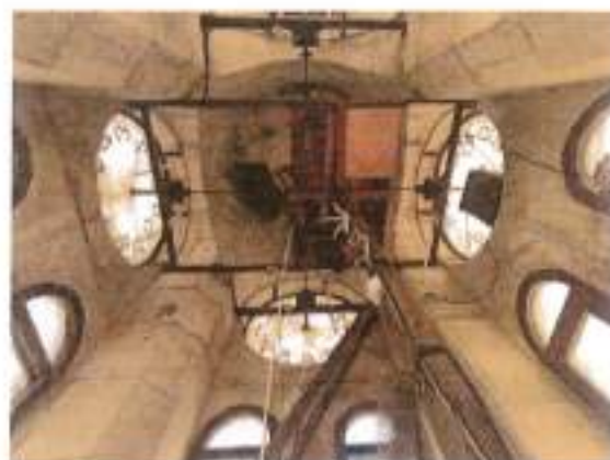
εικ. 4-15: Κατασκευή του κοιτηριού του 5 ου επιπέδου των κωδωνοστασίων.
