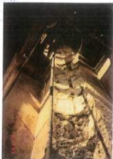
εικ. 5-29: Ν. Κυδωνοστάσιον, Α' Διάδρομος, Ν.Α. Κίονας υπό ανακατασκευή· διακρίνεται η χυτοσίδηρη ράβδος της προηγούμενης φάσης επικοινωνίας και οι δύο διαφορετικές σκυροδέσεις – οδηγεί σύμφωνα με τις οποίες ανακατασκευάστηκαν οι κωνοειδή σπόνδυλοι, τοποθετημένοι σε μετατόπιση μεταξύ τους, ώστε να φρονιστεί η παραμόρφωση του κίονα στη θέση αυτή που οφείλεται σε ποδοκνήμη βλάβη. Δεκέμβριο 1990. Αρχείο Θεωλάκη
