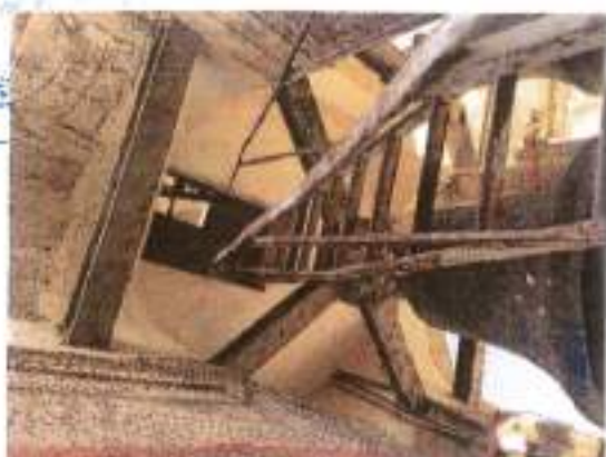
εικ. 3-36: Μεταλλικοί δοκοί από τους οποίους αναστήνεται οι κωδωνες.
