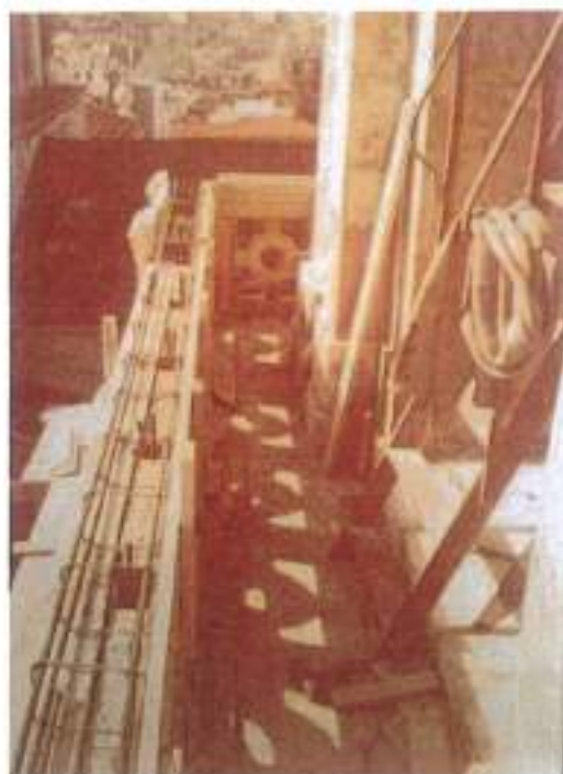
εικ. 5-22: Κατασκευή σπείρας Α' διαδύματος από σκυρόδεμα. Δεκαετία 1980. Αρχείο Βασιλείου
