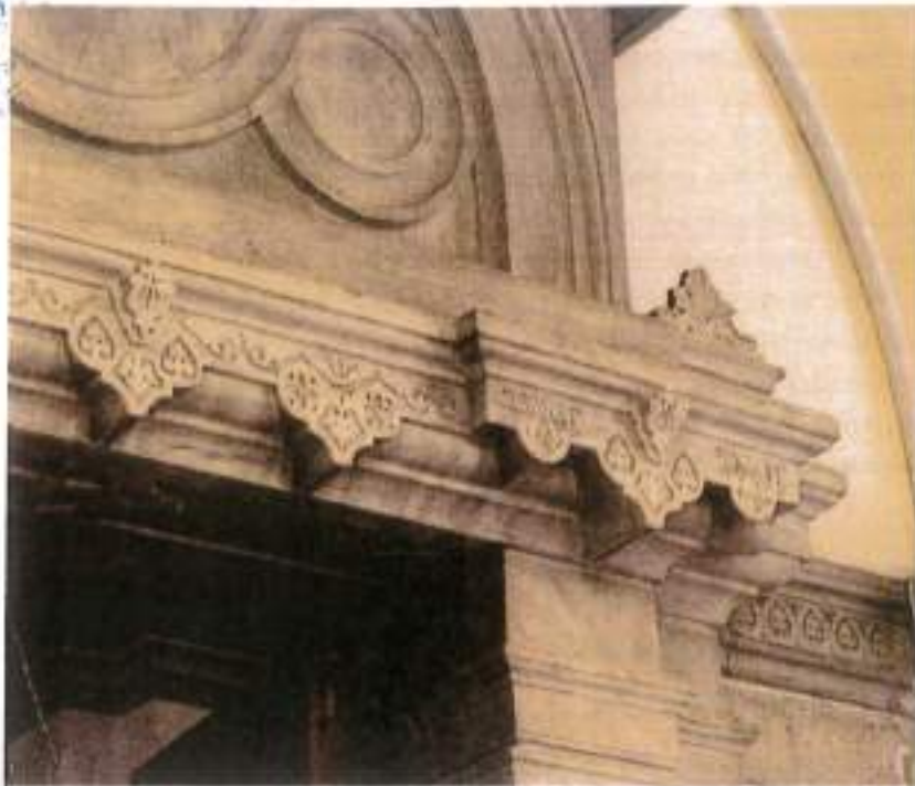
εικ. 3-53: Κορυφή με εναλλαγές ημιφωτονωμάτων και κοιλόκυρτων μετωπών στη βόρεια πλευρική θύρα του ναού
