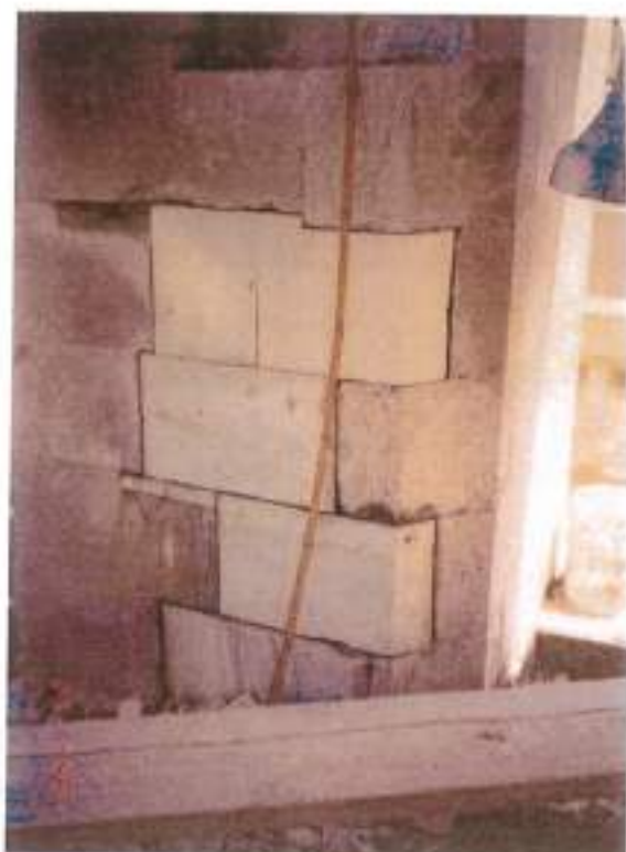
εικ. 5-35: Β. Κουδωνοστάσιον, Α' διαζώμα. Άλλα στον περσό που έχουν αντικατασταθεί, 1993, Αρχείο Βασιλείου
