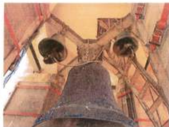
εικ. 4-13: Μεταλλικό διάφραγμα από όπου αναρτώνται οι κωδώνες.
