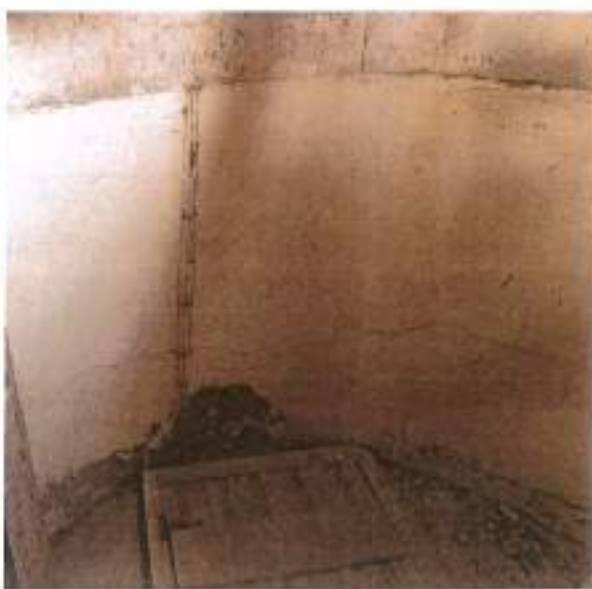
εικ. 6-28: Οριζόντιες στρεπτινές ρωγμές στο γέσο μεταξύ 4 ου και 5 ου επιπέδου Β Κωδωνοστάσιου.
