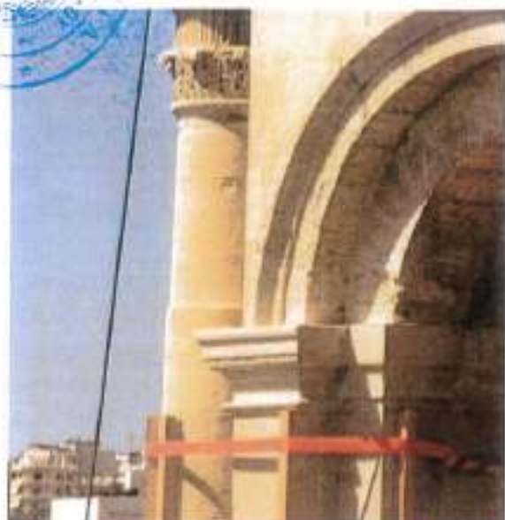
εικ. 6-25: Επίπεδο ολισθήσεως στο επίπεδο της ιδρύσεως των τόξων του 4 ου επιπέδου Β Κωδωνοστάσιου.
