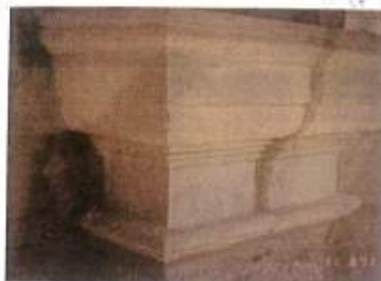
εικ. 5-34: Το κέικρανο ποδαρού του Α' διαζώματος του Β. Κουδωνοστασίου το οποίο έχει ξαναχτιστεί σε δύο μέρη και επανταποθετηθεί στη θέση του, 1993, Αρχείο Βασιλείου
