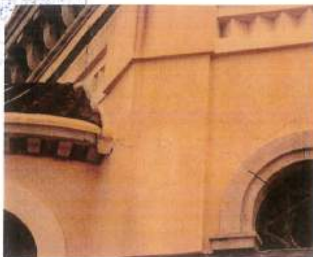
εικ. 6-5: Οριζόντιες διατμητικές ρωγμές στους πεσσούς του οκταγώνου
