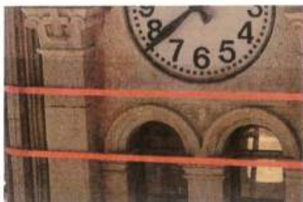
εικ. 6-29: Οριζόντιο επίπεδο αστοχίας κάτω από το ρολόι του 5 ου επιπέδου και πάνω από τα δίλοβα παράθυρα
