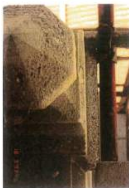
εικ. 5-26: Ν. Καδινωσιτόπου, Β' Διοίκηση, 8ά Γυνία, διάβρωση διακοσμητικού στοιχείου στηθείου το οποίο έχει ανακατασκευαστεί στην προηγούμενη τρέση επισκευών, 1993, Αρχείο Βασιλάνη
