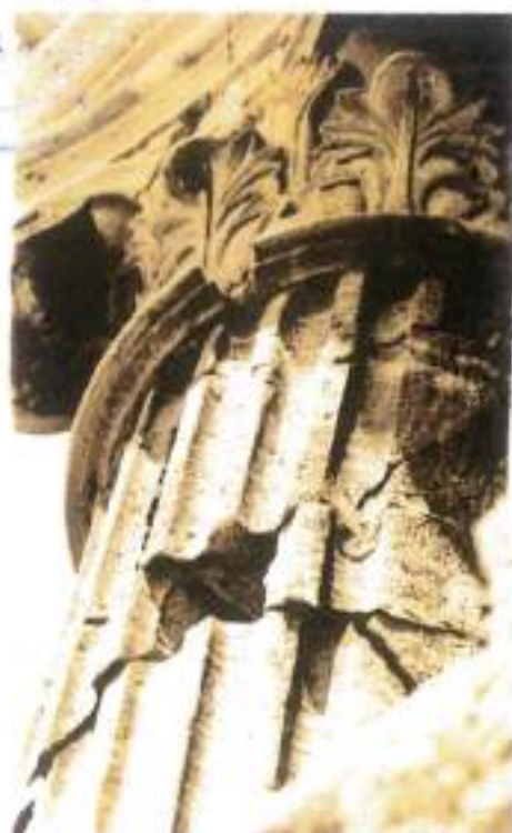
εικ. 5-8 Ρυγμές σε κίονα του Β' Διαζώματος Καθολιστάσιου, 1979. Αρχείο Βασιλείου
