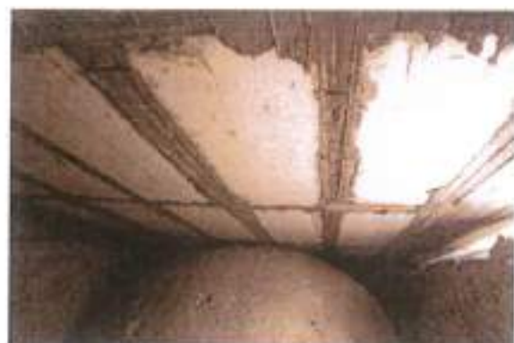
εικ. 4-10. Δοκωτή πλάκα πάνω από τους θαλάκους των γυναικών διαμερισμάτων.
