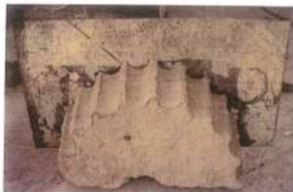
εικ. 5-33: Τμήμα από τον σπόνδυλο κίονα του Β' διαζώματος του Β. Κουδωνοστασίου. Αποτυπώνεται η διάταξη του σε λαμπρίνα προκειμένου στη συνέχεια να δοθεί σε ξυλουργό για να φτιάξει το καλούπι στο οποίο θα γίνει η έγχυση του σκυροδέματος του νέου κίονα, 1993, Αρχείο Βασιλείου
