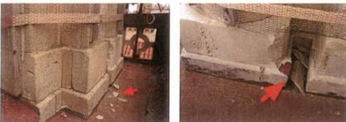
εικ. 6-57 : Βράσματα που αποσπάστηκαν από διάφορους λίθους στο βόρειο κωδωνοστάσιο
